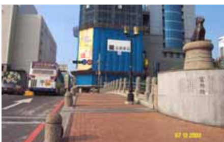
現況 7. 基隆市田寮河富狗橋 杜文郁 攝
