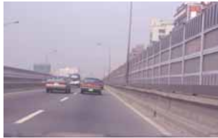
現況 1. 建國高架橋 郭瓊瑩 攝
