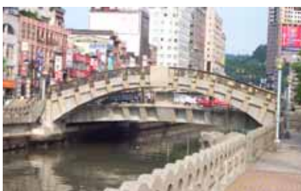
現況 8. 基隆市田寮河橋杜文郁 攝
