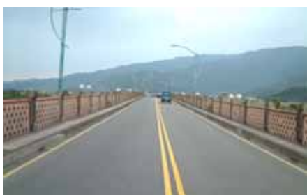
現況 6. 宜蘭縣台七丙線泰雅大橋 蕭俊仁 攝
